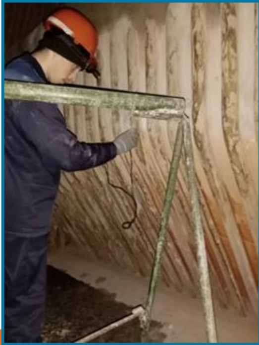
Неразрушающий контроль котельного оборудования
