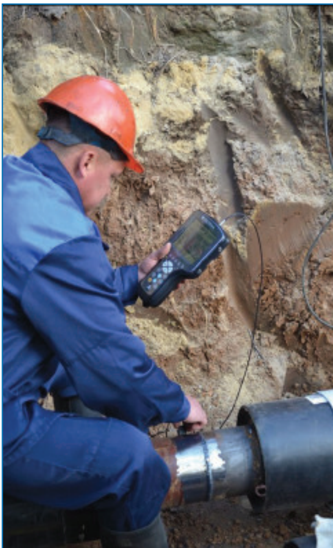
Рисунок 17. Входной контроль качества сварного шва.
