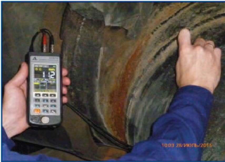
Рисунок 16. Проверка отремонтированного участка сети с помощью ультразвукового толщиномера.
