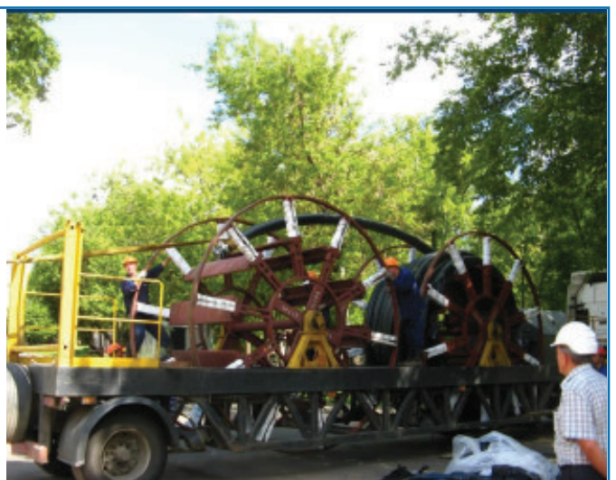
Рисунок 15. Монтаж трубопроводов из сшитого полиэтилена на объекте.
