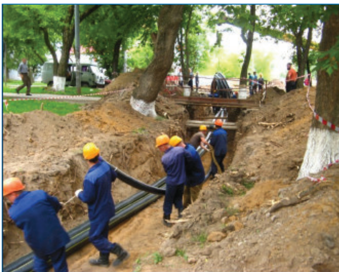
Рисунок 15. Монтаж трубопроводов из сшитого полиэтилена на объекте.
