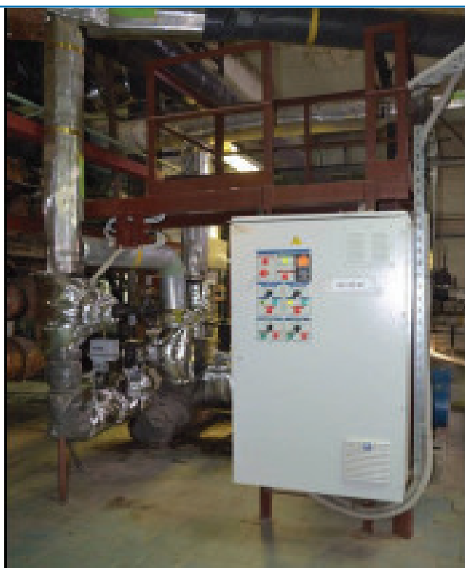
Рисунок 19. Диспетчерский пункт и мнемосхема автоматизированного ЦТП № 2..
