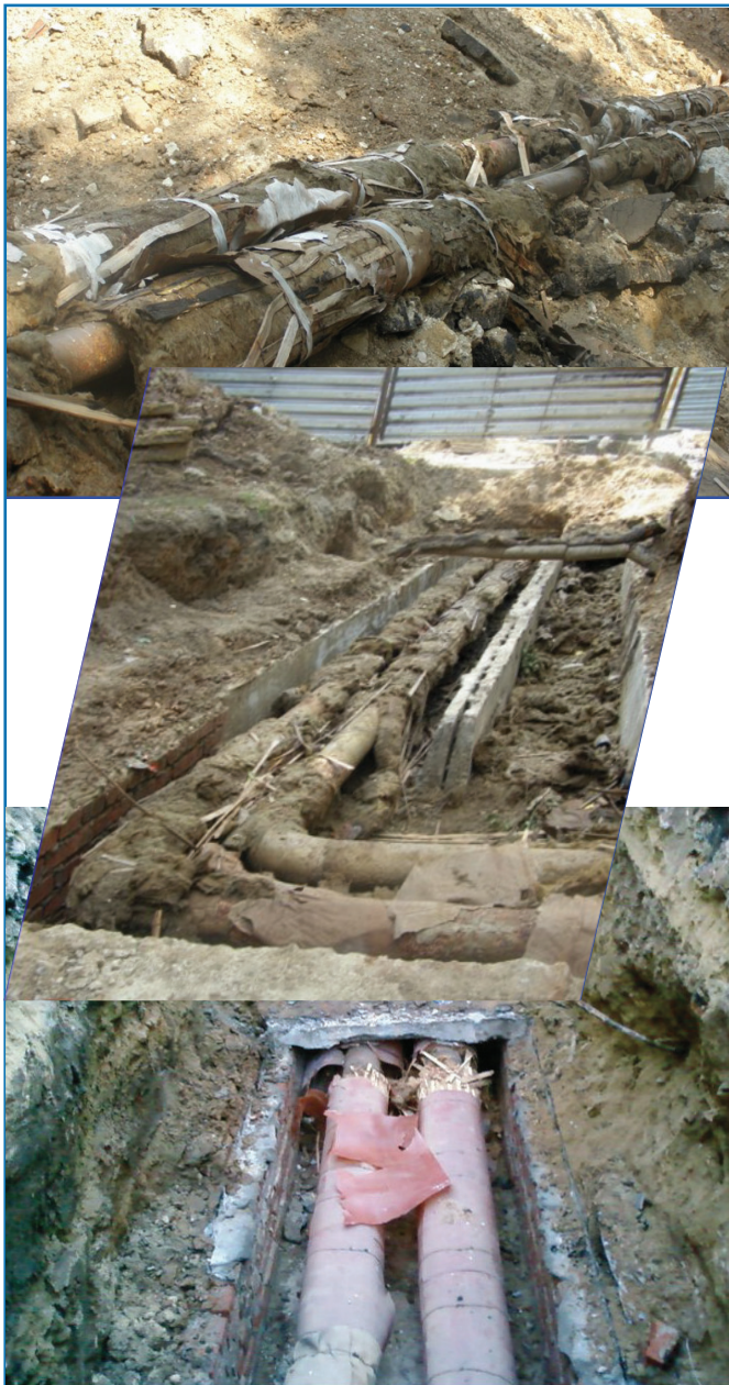
Рисунок 3. Состояние тепловых сетей, переданных в муниципальное управление.
