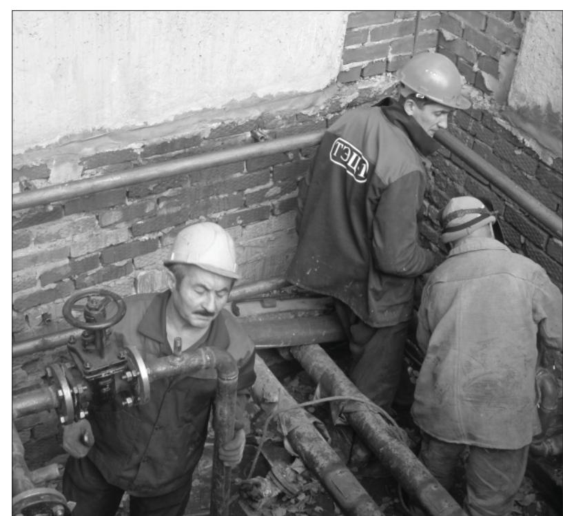
бор элеваторов, расчет сопел и дроссельных шайб. Механическая мастерская изготовила корпуса элеваторов. Отдел снабжения обеспечил выполнение заказа на трубную продукцию, запорную арматуру, КИПиА и прочие – необходимые материалы.
