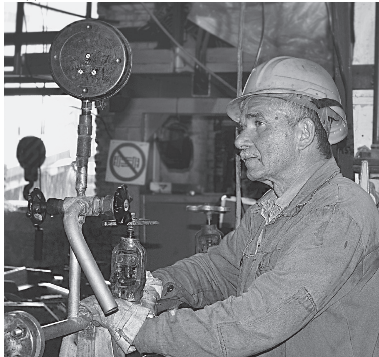
повышение давления в котле во время гидравлических испытаний.
