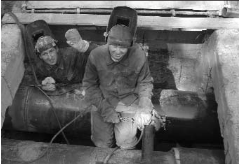
В прошлом номере начальник ЦЦРиС В.А. Полханов рассказал о том, какую работу выполняли строители по реконструкции теплосети по ул. Волкова в июне. А как обстоят дела сейчас? Слово Владимиру Аркадьевичу.
