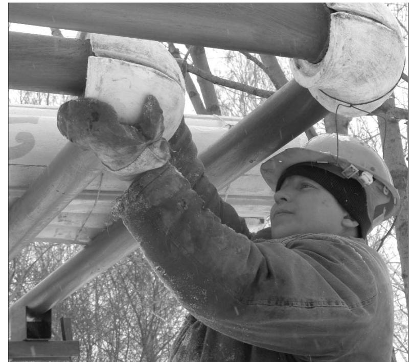
ровано 4 участка тепловых сетей, в том числе полная замена труб в канале на участке от ТК-10 до ТК-12 протяженностью 72,5 м на предыдущие, ремонт 44 м теплотрассы Ду50 мм к детскому саду №16.
