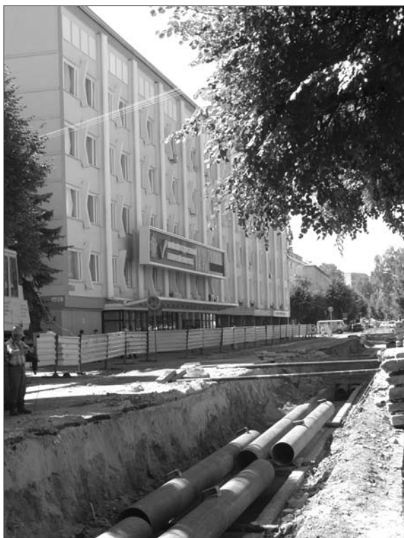
За прошедшие полгода нашим цехом проведен большой объем ремонтных работ.
